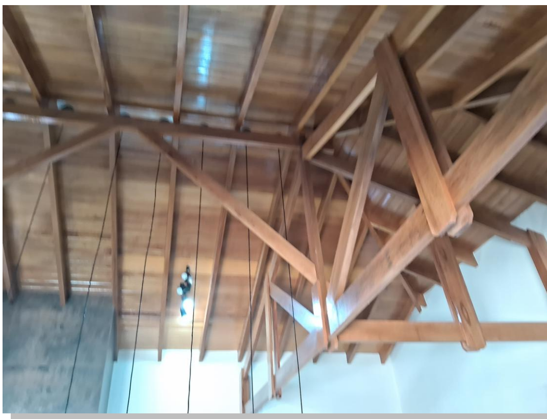
Foto 13 – Foto com Vista do Teto em madeira maciça e iluminação rebaixada.
