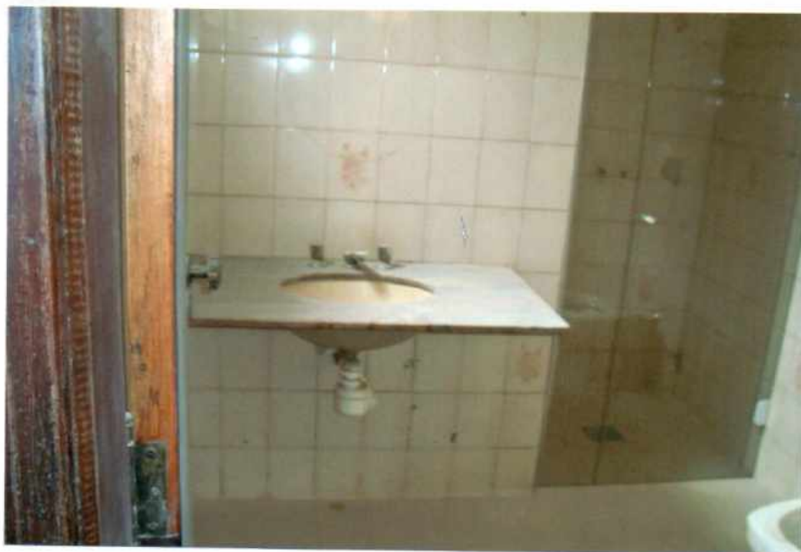
Vista parcial do piso com ardósia e banheiro no pavimento superior.
