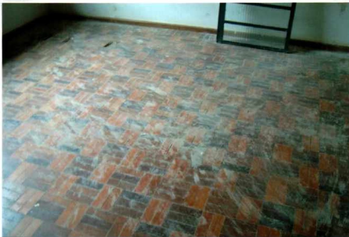
Vista parcial do interior da sala com forro de laje e piso com tacos de madeira.
