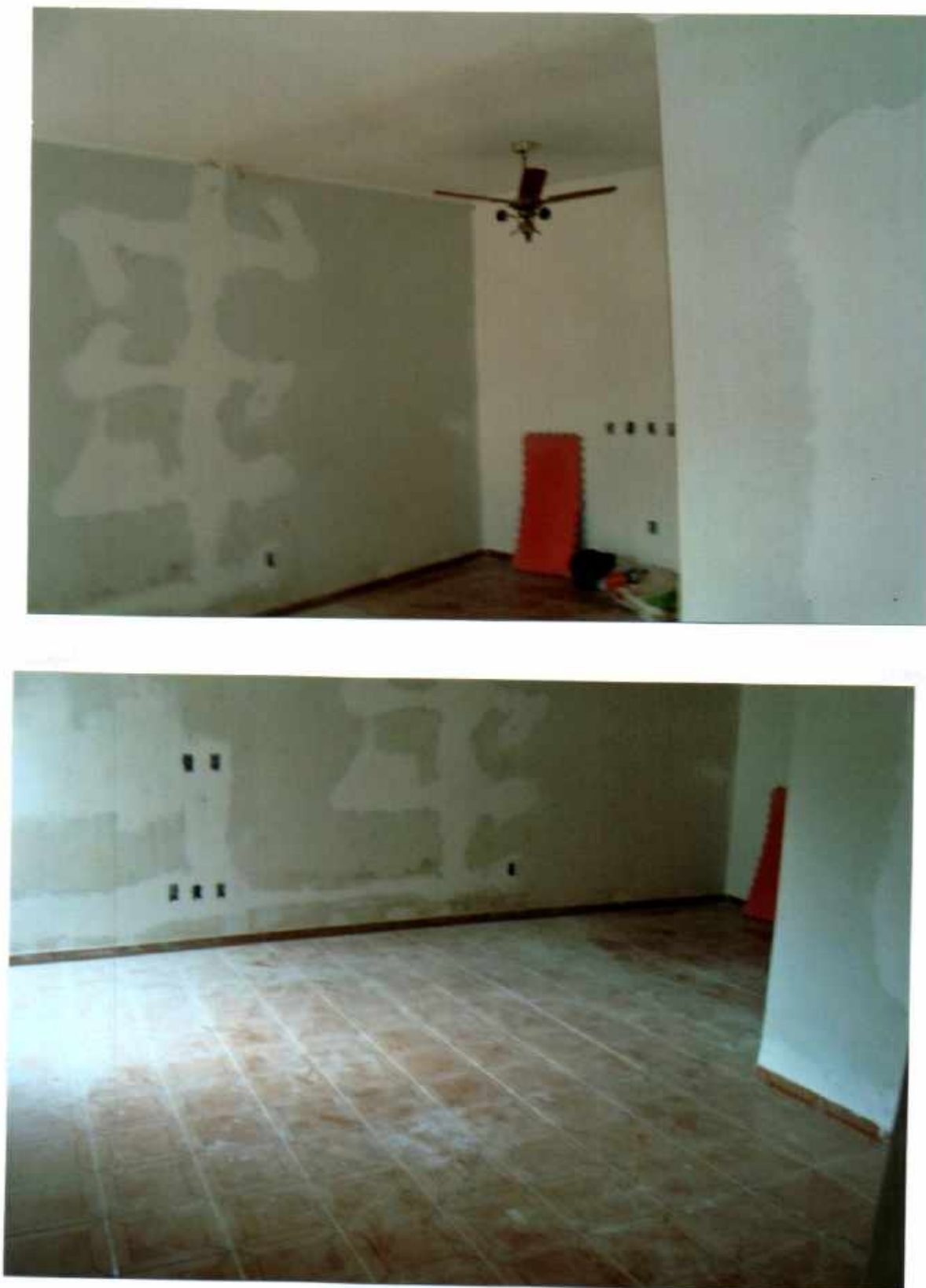
Vista parcial do interior da sala no pavimento superior.
