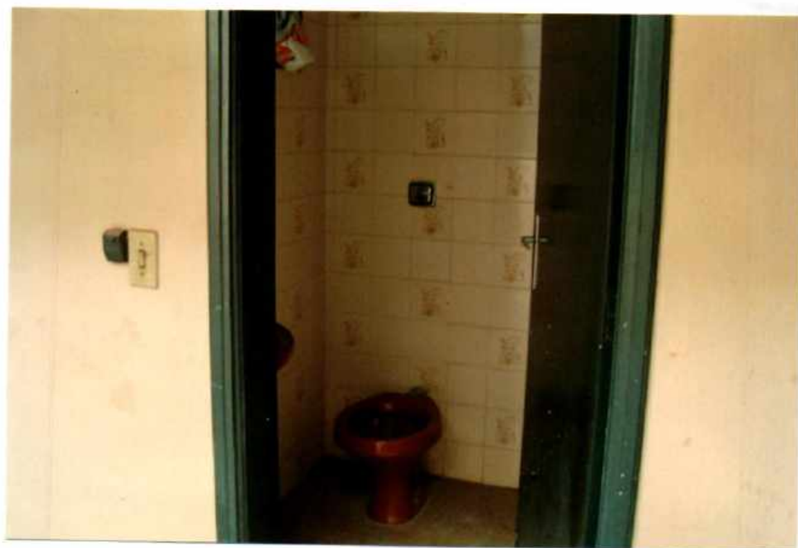
Vista parcial do interior de um dos sanitários e interior do lavabo.
