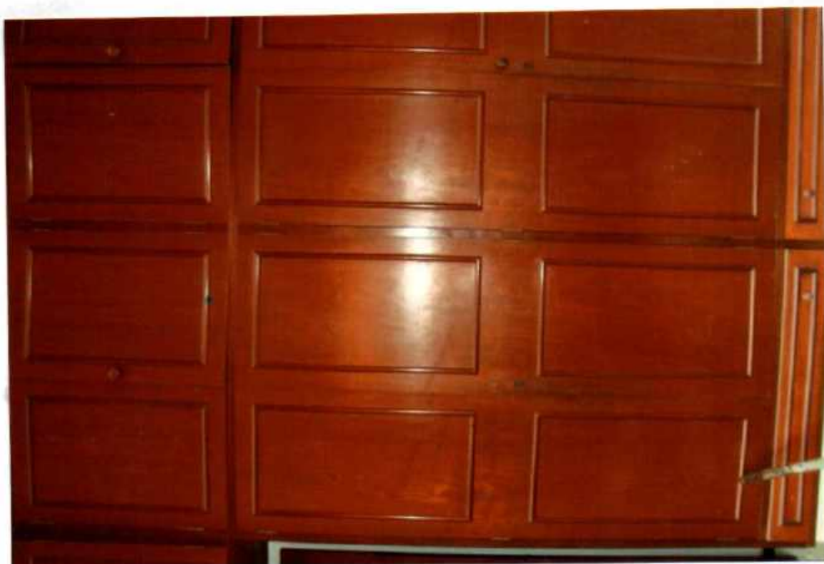
Vista parcial dos tipos dos armários embutidos existentes nos dormitórios.
