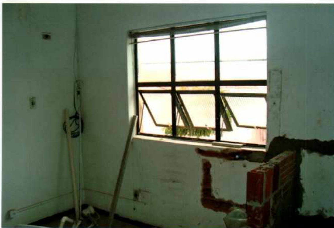
Vista parcial do interior da cozinha no pavimento superior, totalmente com reforma.
