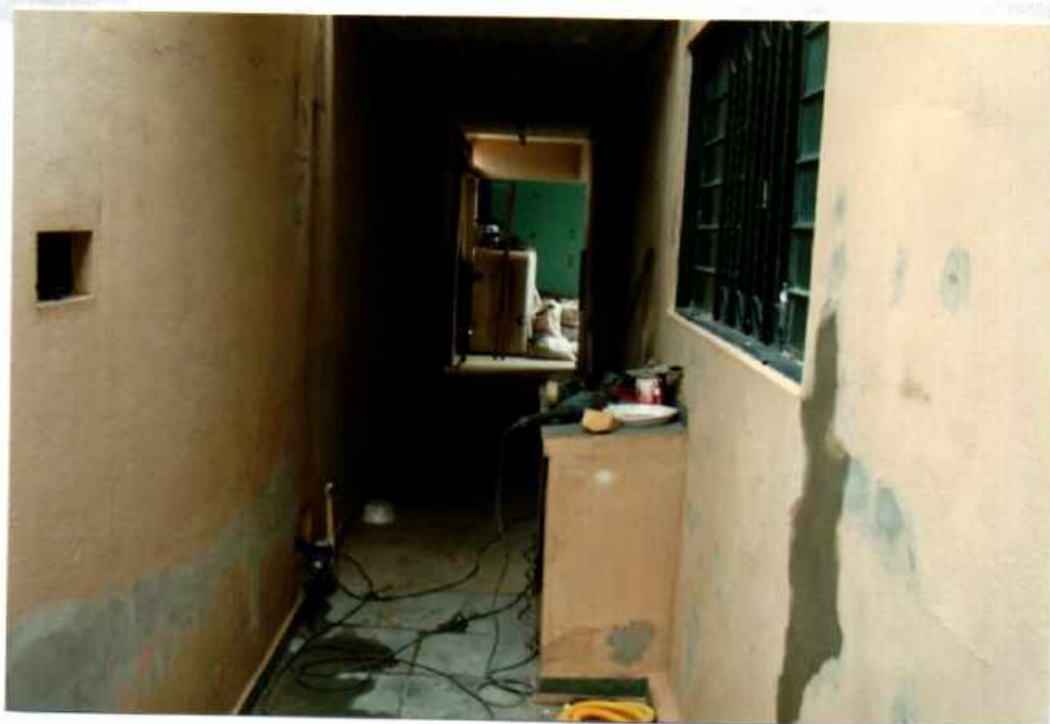
Vista parcial dos corredores de acesso aos dormitórios e área de serviço.
