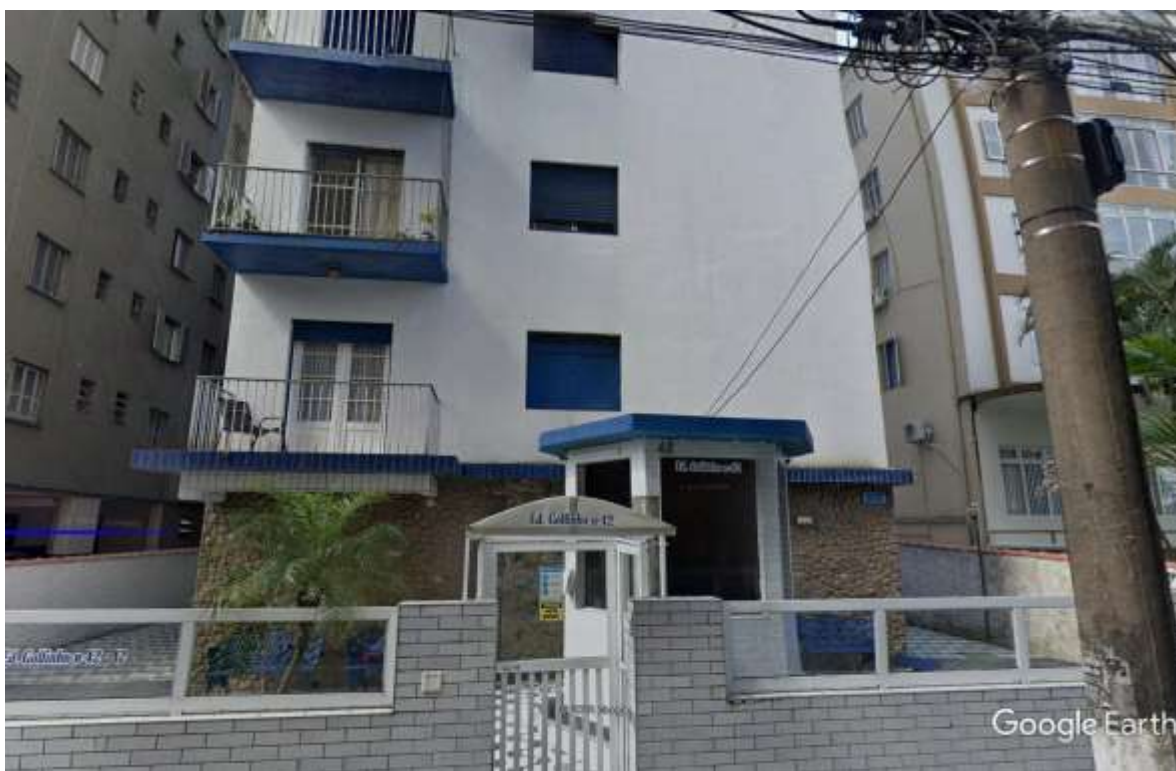
FOTO 3 – VISTA FRONTAL DA EDIFICAÇÃO
