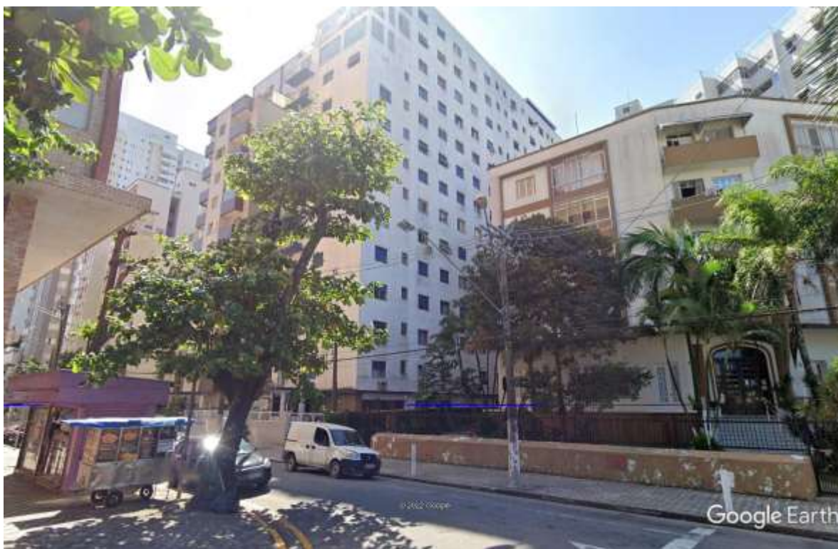
FOTO 2 – VISTA DA EDIFICAÇÃO
