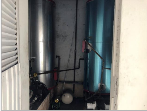
Foto 19 – Sala Técnica (Boilers)
