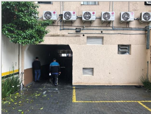
Foto 23 – Vista da parte posterior da edificação
