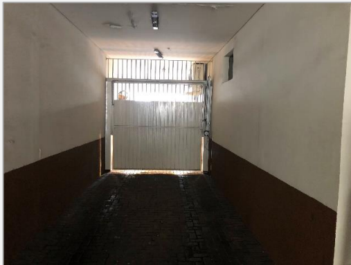
Foto 15 – Portão de acesso ao estacionamento
