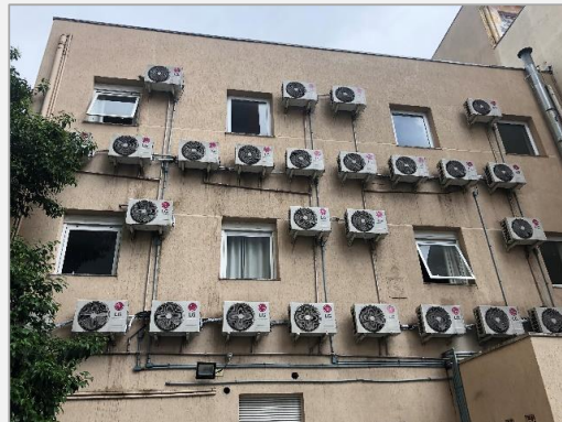
Foto 24 – Vista da parte posterior da edificação
